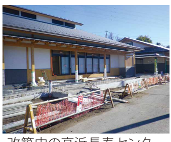
改築中の高浜長寿センター
